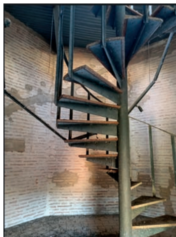
Fig. 2. Detalle de la escalera interior de la torre de Olalla
