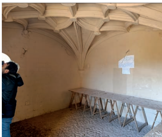
Fig. 3. Interior del primer cuerpo de la torre de Olalla
