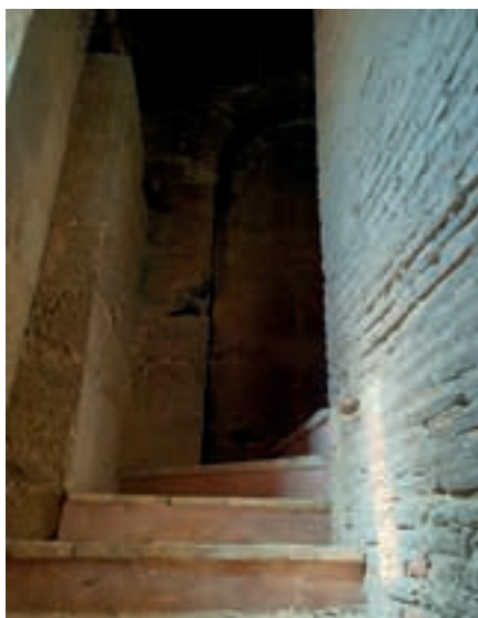
Fig. 15. Detalle escalera interior de la torre de Báguena
