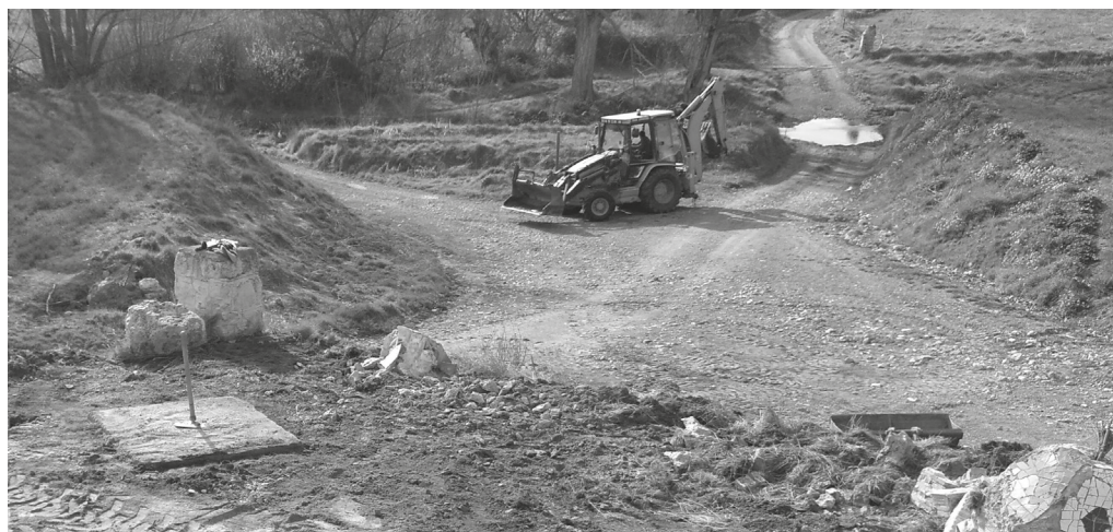
Preparación del terreno
