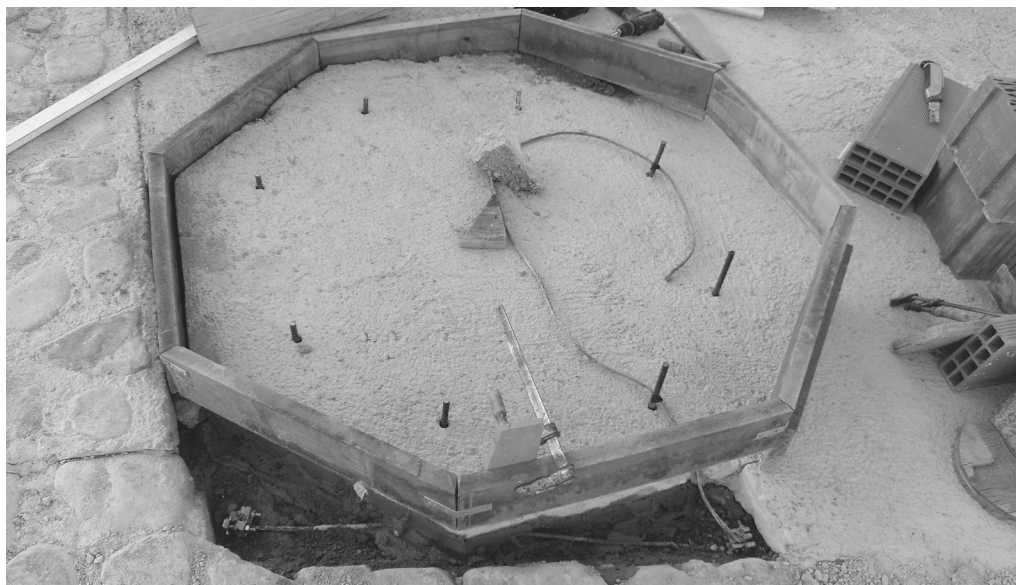
Colocación de la toma de tierra
