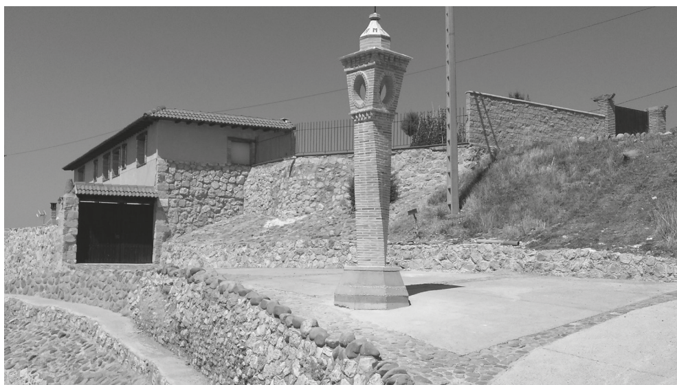
30 julio retirada de andamios y limpieza
