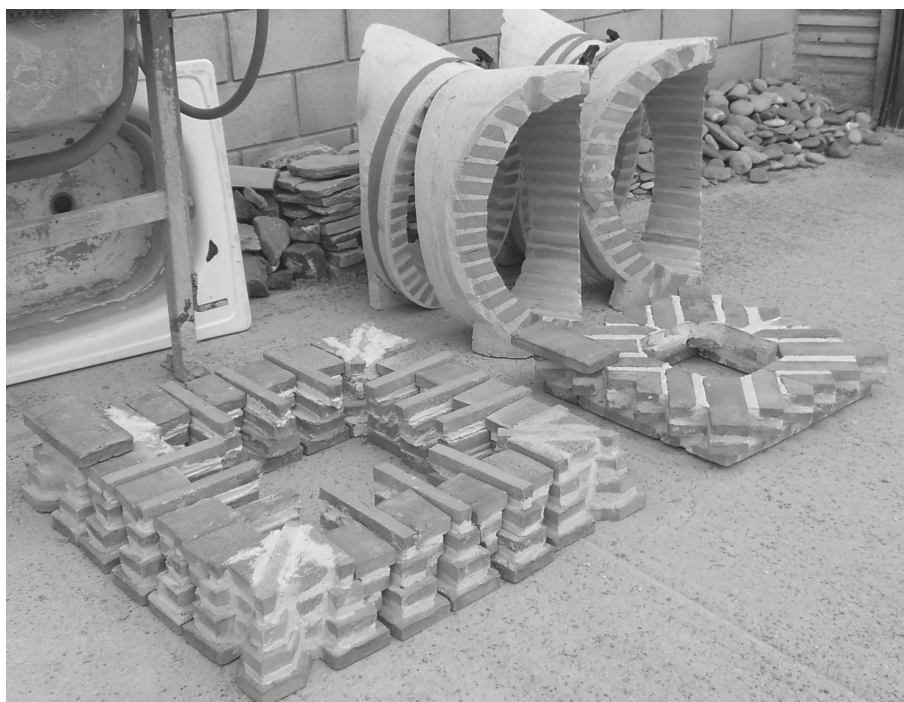
Los prefabricados listos para su traslado
