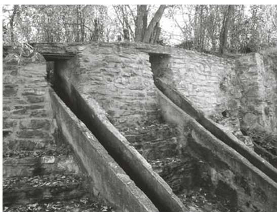
Los dos canales a través de los cuales el agua de la balsa cae a gran velocidad para mover el rodézno del molino harinero. Fuente: CEJ.
