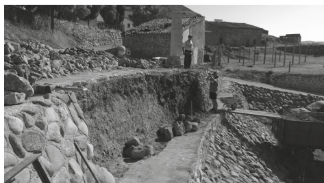
Desmontaje del muro con Vicente y Juan José
