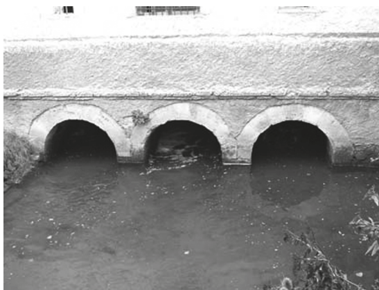
Los tres cárcavos del molino harinero por donde sale al agua tras mover el rodezno. Fuente: CEJ.
