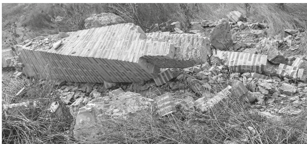
Derribo del fuste
