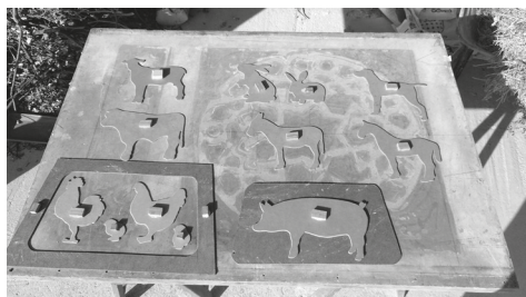
Preparación del esgrafiado
