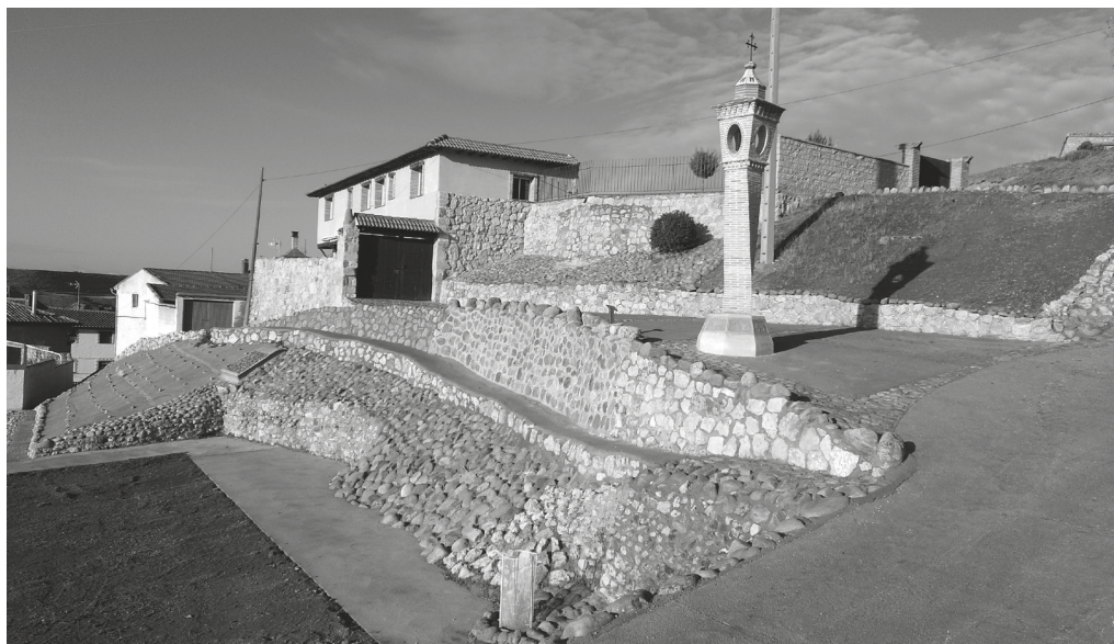
Los trabajos han terminado
