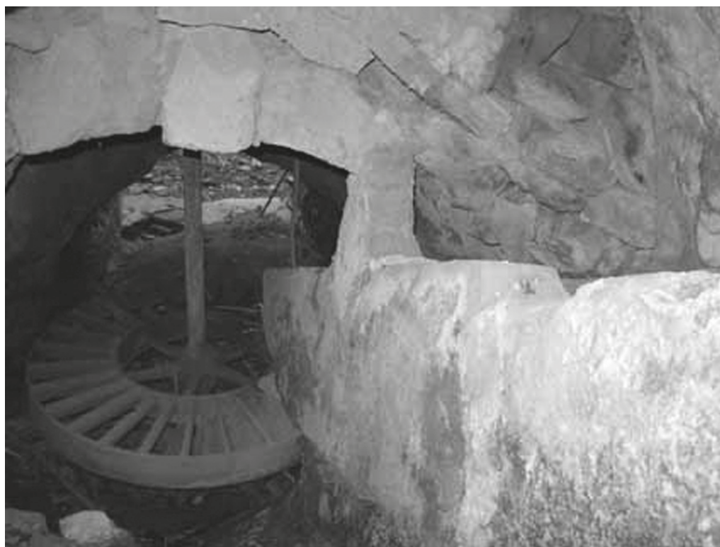
Rodezno metálico cuyos alabes reciben el impacto del agua de la balsa cayendo a gran velocidad para mover el eje y las muelas del molino. Fuente: CEJ.
