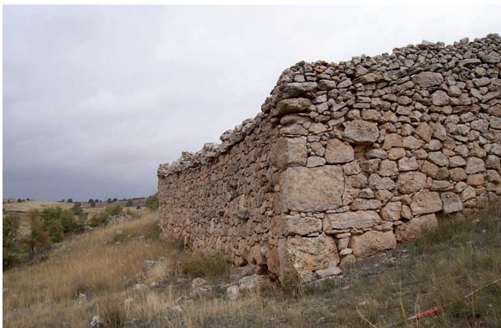
Muros recrecidos de la paridera del Corral del Fraile (Bañón). Foto: J.A. Sánchez.
