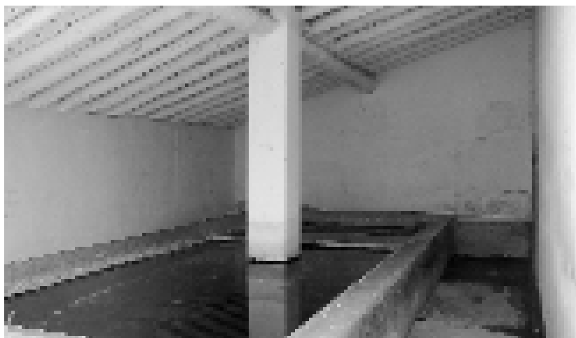
Interior del lavadero.
