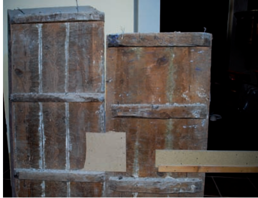
Figura 8. Reverso. Estado inicial. Proceso de desmontaje.
