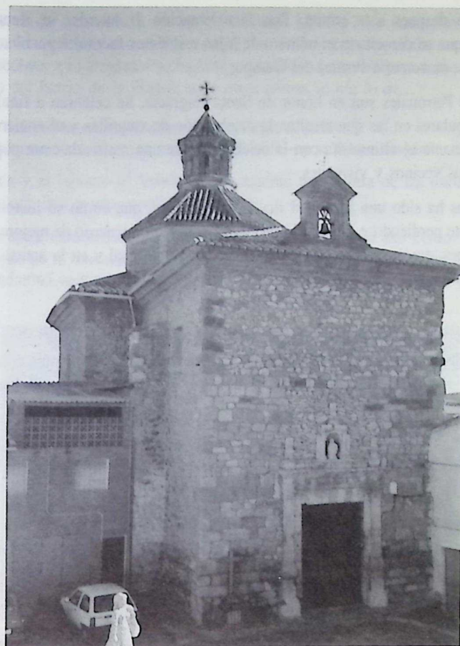
Ermita de Santa Engracia. En el mismo centro de la localidad. (Foto A. Alcañiz)
