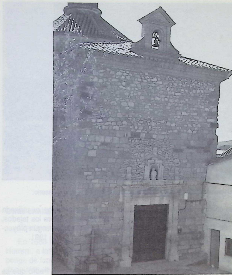
Fig. 6. Fachada de la ermita de Santa Engracia
