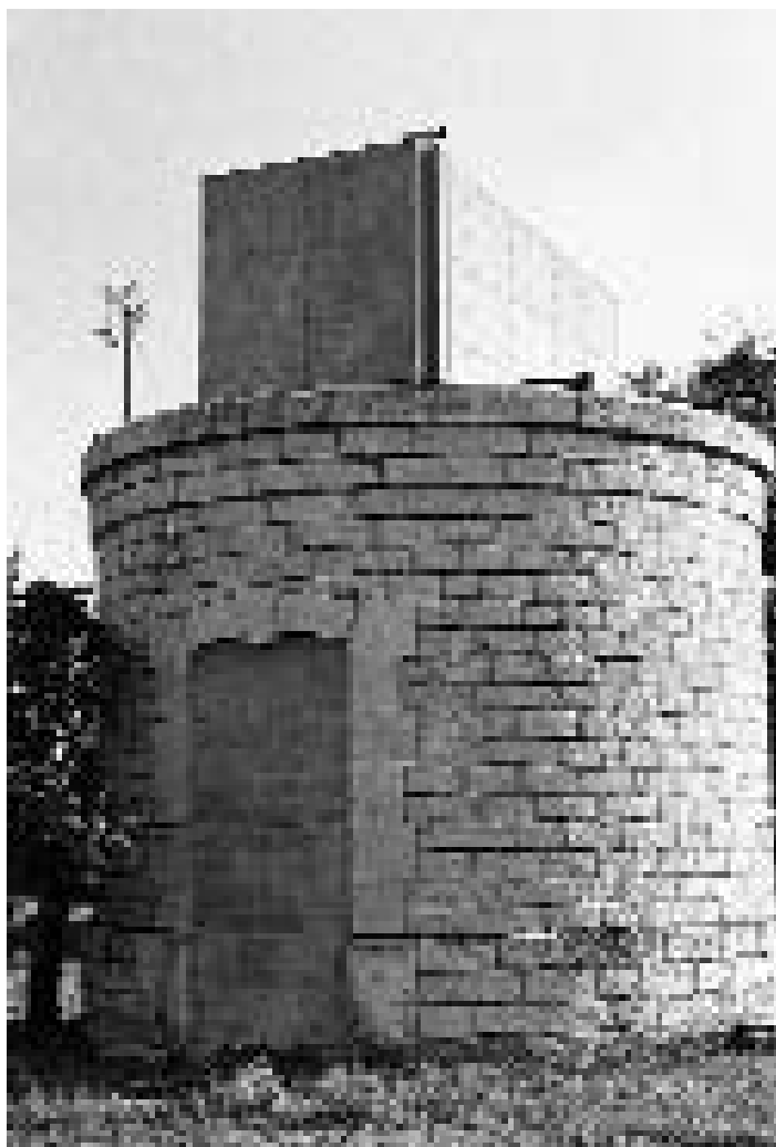
Aspecto del depósito de agua. En este caso el tapiado del acceso ha servido para que se respetase el interior (foto: J. Serafín Aldecoa Calvo).
