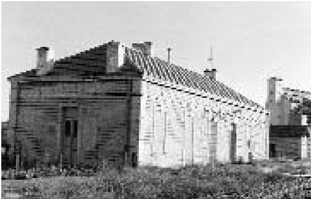
Estación de Monreal del Campo: aspecto reciente (noviembre de 1999). Obsérvese el abandono y deterioro actual: no existe ya el cartel con el nombre de la localidad y el reloj, tan interesante en otra época, ha desaparecido. Además, una de las entradas que fueron tapiadas ha sido agujereada para entrar dentro. Al fondo, el silo de cereales (foto: J. Serafín Aldecoa Calvo).
