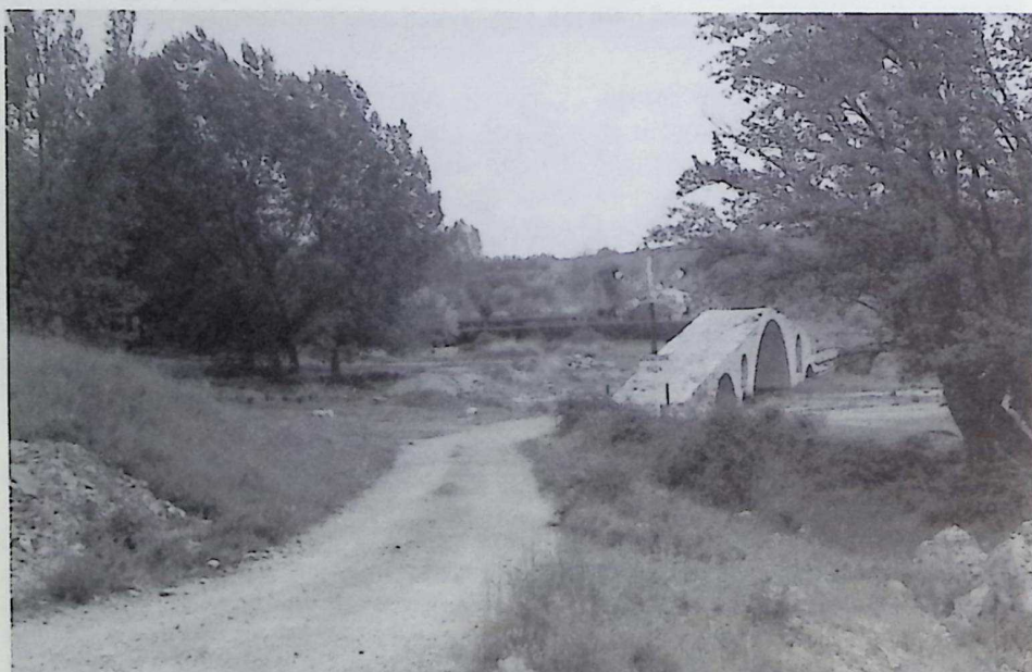
La acequia Molinar atravesando con un sifón el cauce del río Pancrudo.
