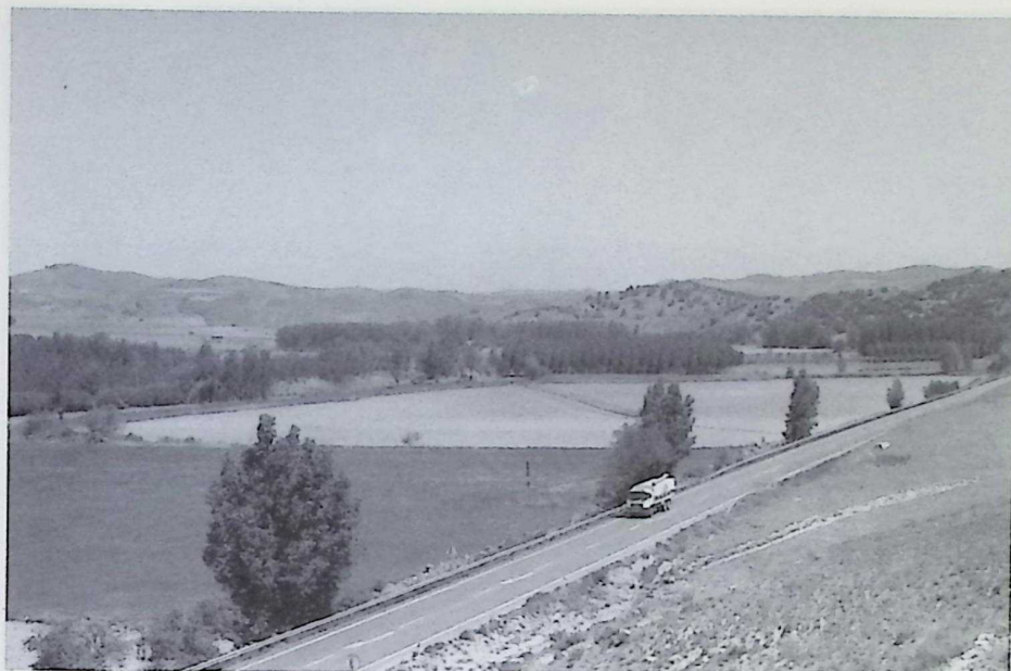
Vista general del antiguo Prado del Camino.
