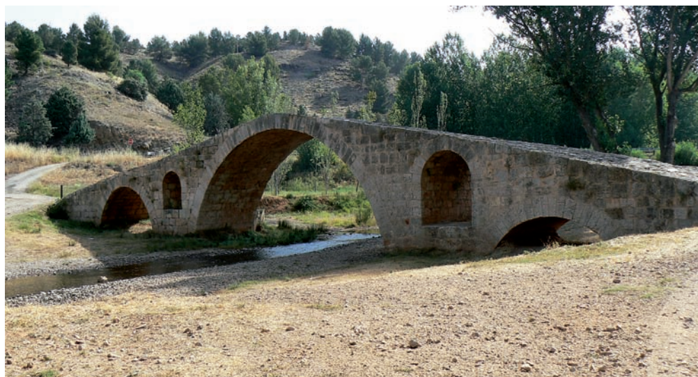
Frontal oeste del puente de Entrambasaguas.
