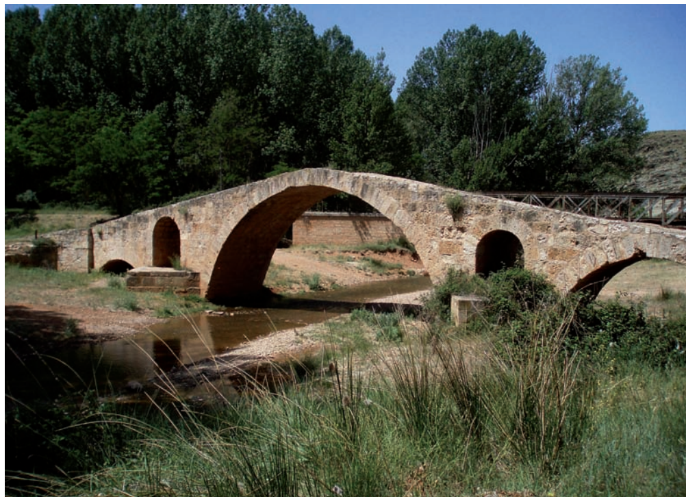
Frontal este del puente de Entrambasaguas.
