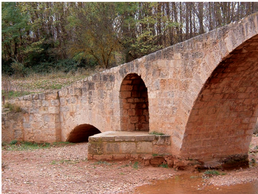
Puente de Entrambasaguas. Detalle de los tajamares triangulares, en el sector este.
