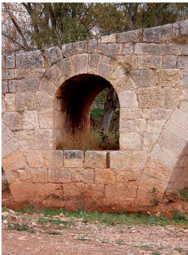
Puente de Entrambasaguas. Detalle de un arquillo de aligeramiento elevado en el sector oeste.
