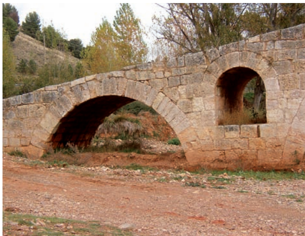
Puente de Entrambasaguas. Detalle del aliviadero en el sector oeste.
