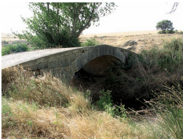
Puente de la Almada, con una capa de cemento sobre el pavimento para facilitar actualmente el paso de vehículos agrícolas.
