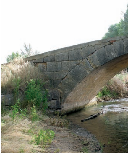
Detalle de los arranques del puente de la Almada, los únicos elementos anteriores al siglo XV.
