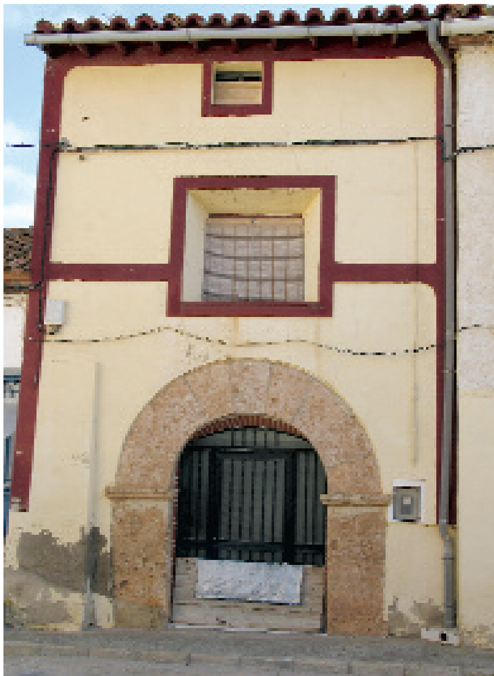
Casa en plaza de la iglesia.
