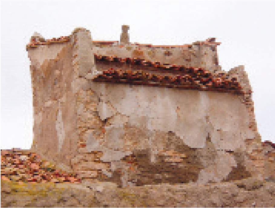
Palomar situado sobre el tejado de la fonda.
