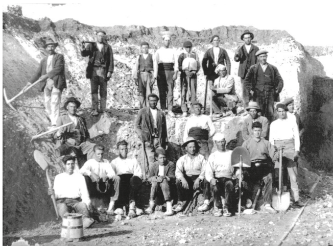
Trabajadores del ferrocarril “El Caminreal”
