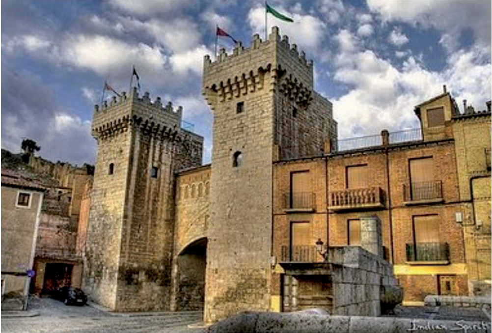
Un paseo por el riquísimo patrimonio de Daroca y un poco de atención desvela los efectos en las zonas más vulnerables de muchos edificios históricos.
