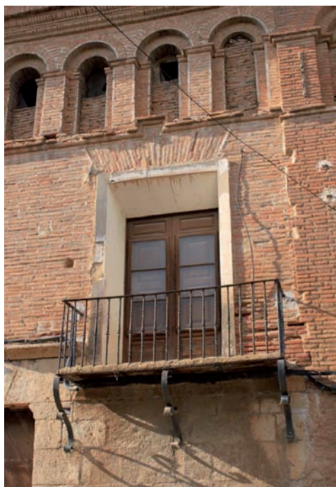
Detalle de un balcón de la fachada. Foto Tomás Guitarte, 2010.
