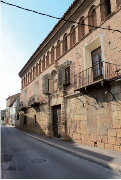
Detalle de la fachada, 2010. Foto Tomás Guitarte.
