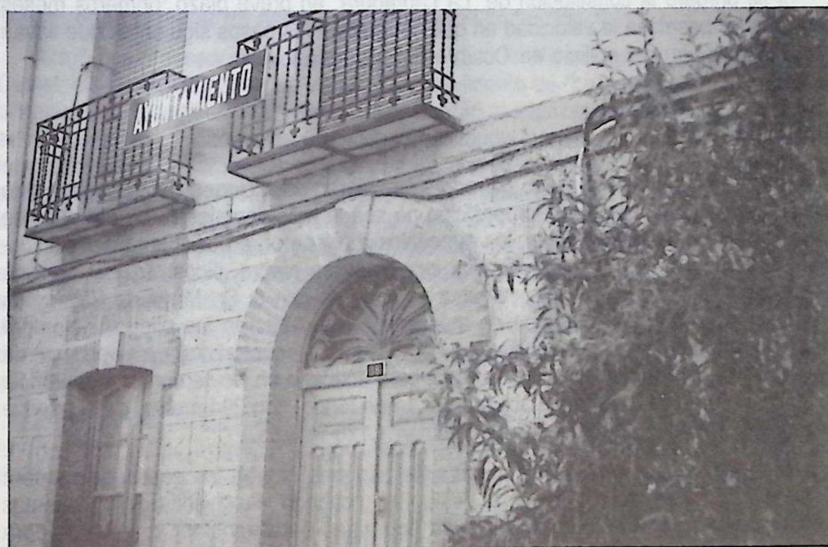
Detalle de construcción. Primera planta de piedra de sillería y ladrillo, el resto de muros y fachada en mampostería al uso.
