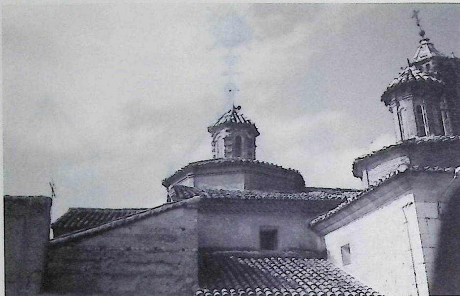
Detalle del cimborrio central de la iglesia.
