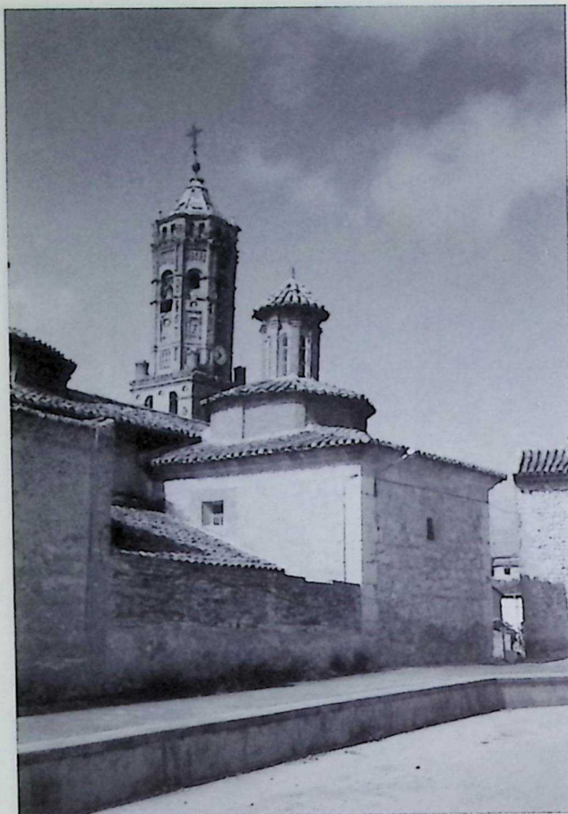
Ábside de la iglesia primitiva en el que se aprecia la cornisa de piedra y una mampostería mejor trabajada.
