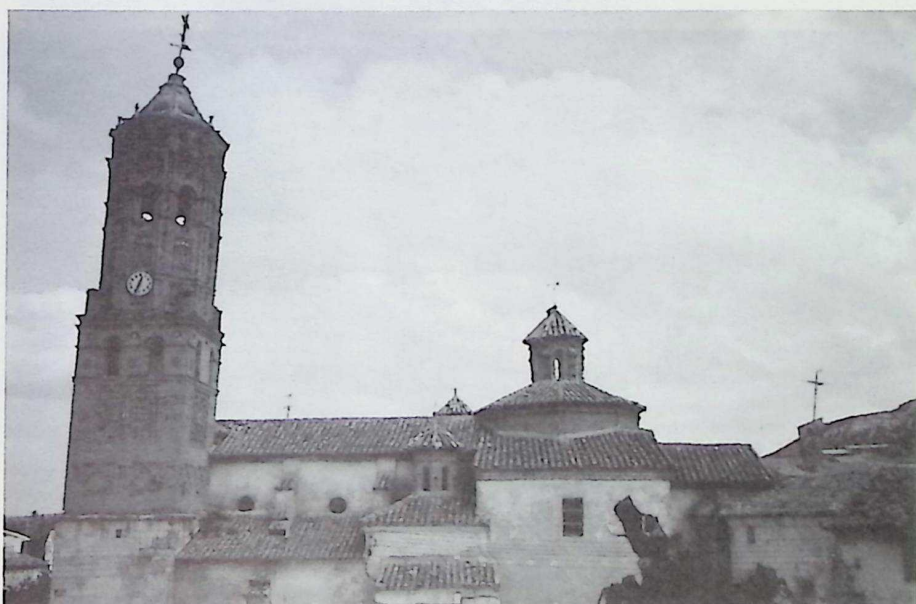
Vista de la iglesia en la que se puede apreciar la inclinación de la torre y la de la linterna de su cimborrio central.
