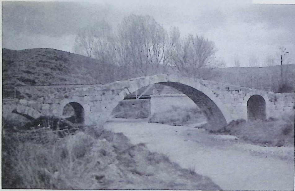
Vista del puente aguas abajo
