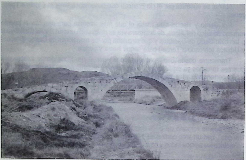
Vista general del puente
