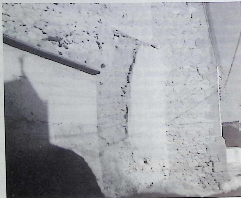
Foto b. Restos del muro exterior de la fortaleza.
