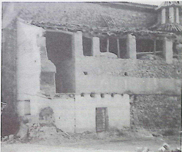
Foto d. Pared de la Iglesia incompleta.
