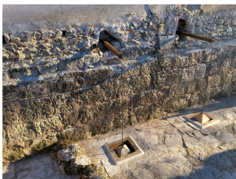
Detalle de los tapones de la balsa, manejables desde el taller mediante un sistema de cuerdas y pértigas.
