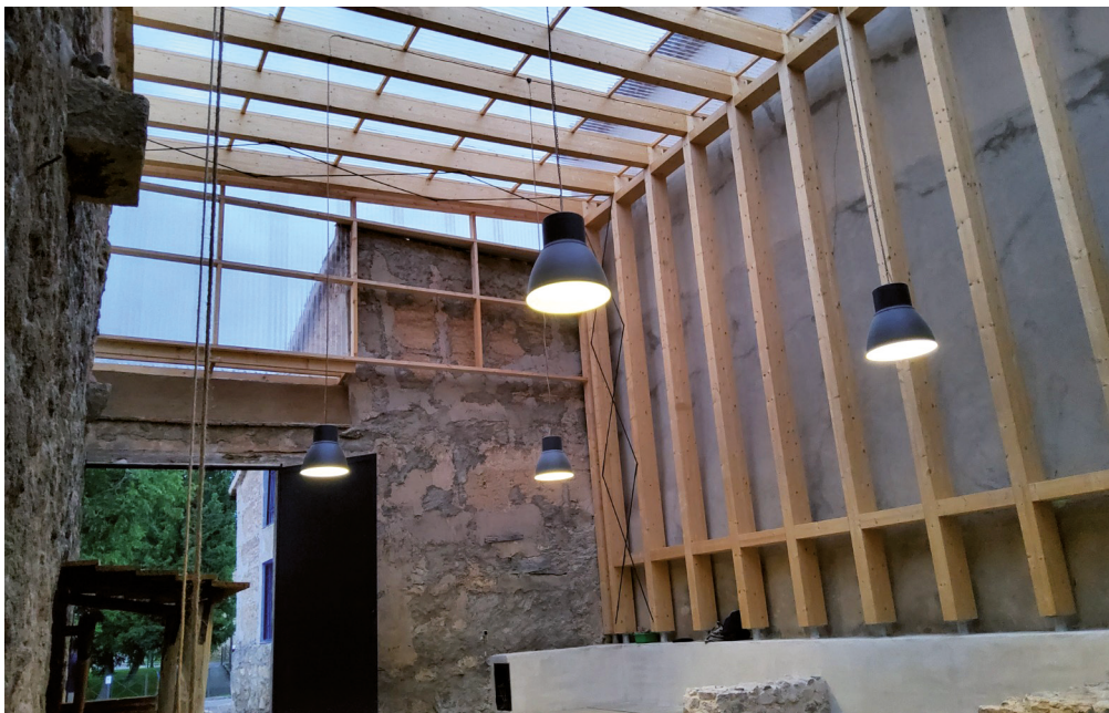
Cubierta de madera utilizada para la protección de los restos del martinete
