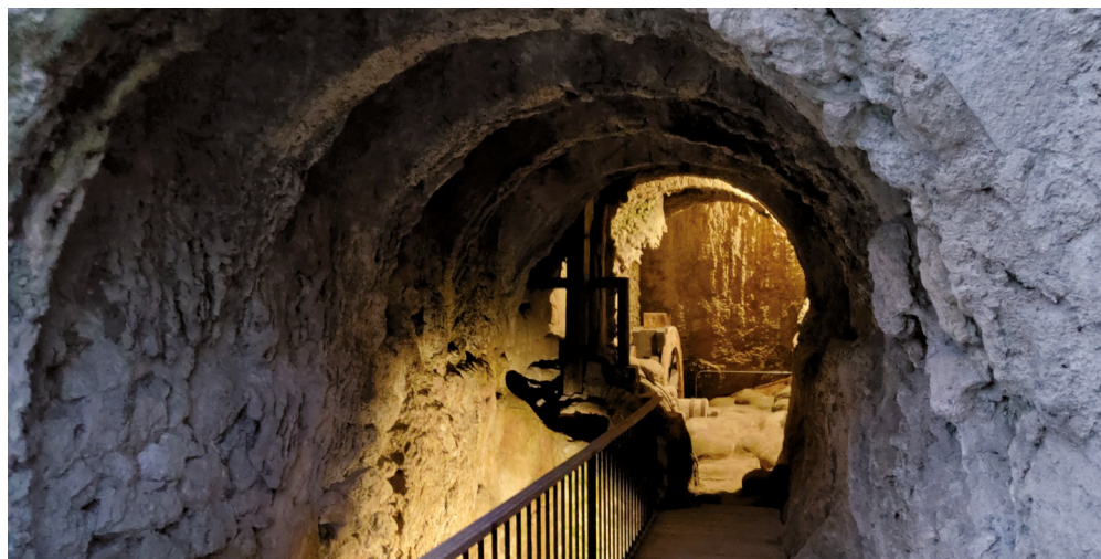
Vista del cárcavo con la nueva iluminación
