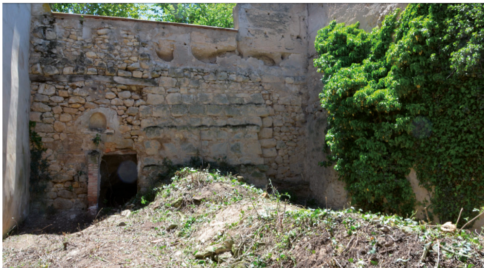
Vista general del taller del martinete previa a los trabajos de limpieza.
