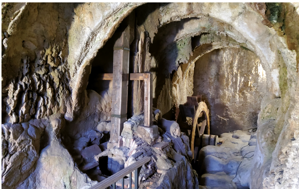
Vista general del cárcavo con el cañón de la trompa de soplado (delante) y la noria (al fondo).
