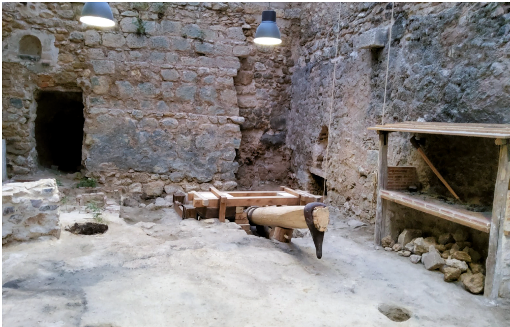
Taller de calderería tras su reconstrucción
