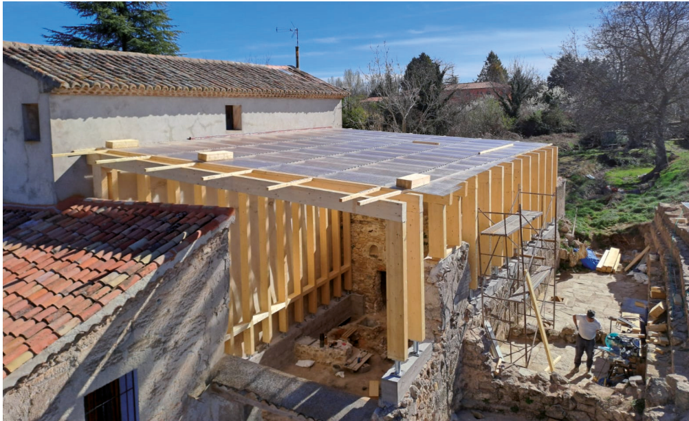
Vista general de la instalación de una cubierta de madera y plástico transparente.
