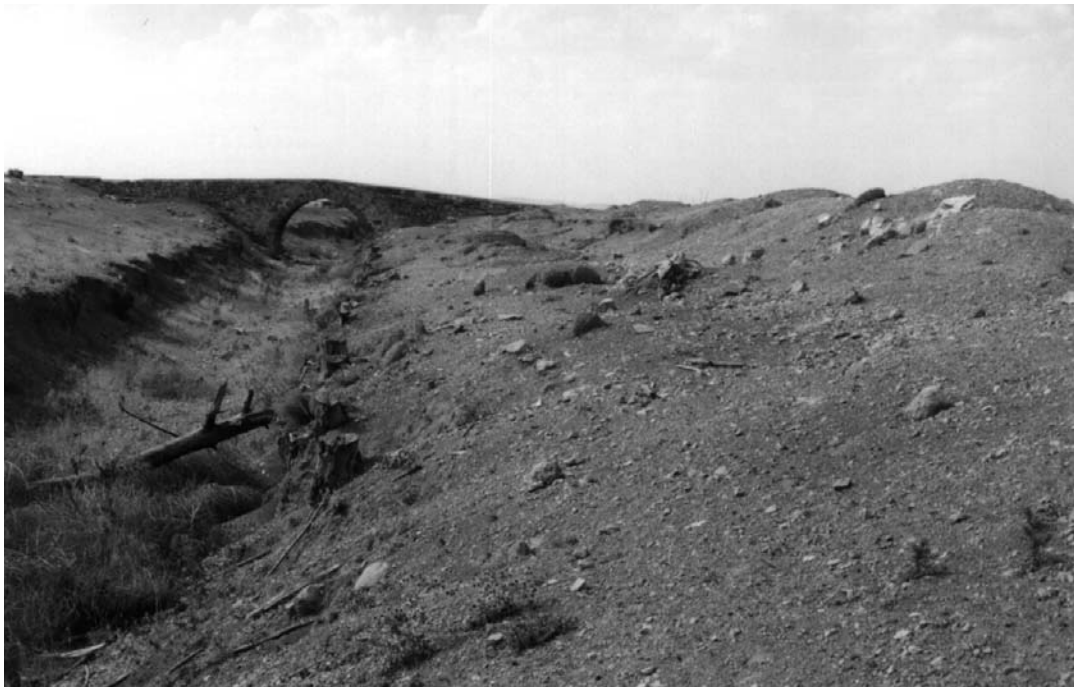
Puente de la Juanseca en el río Cella.
