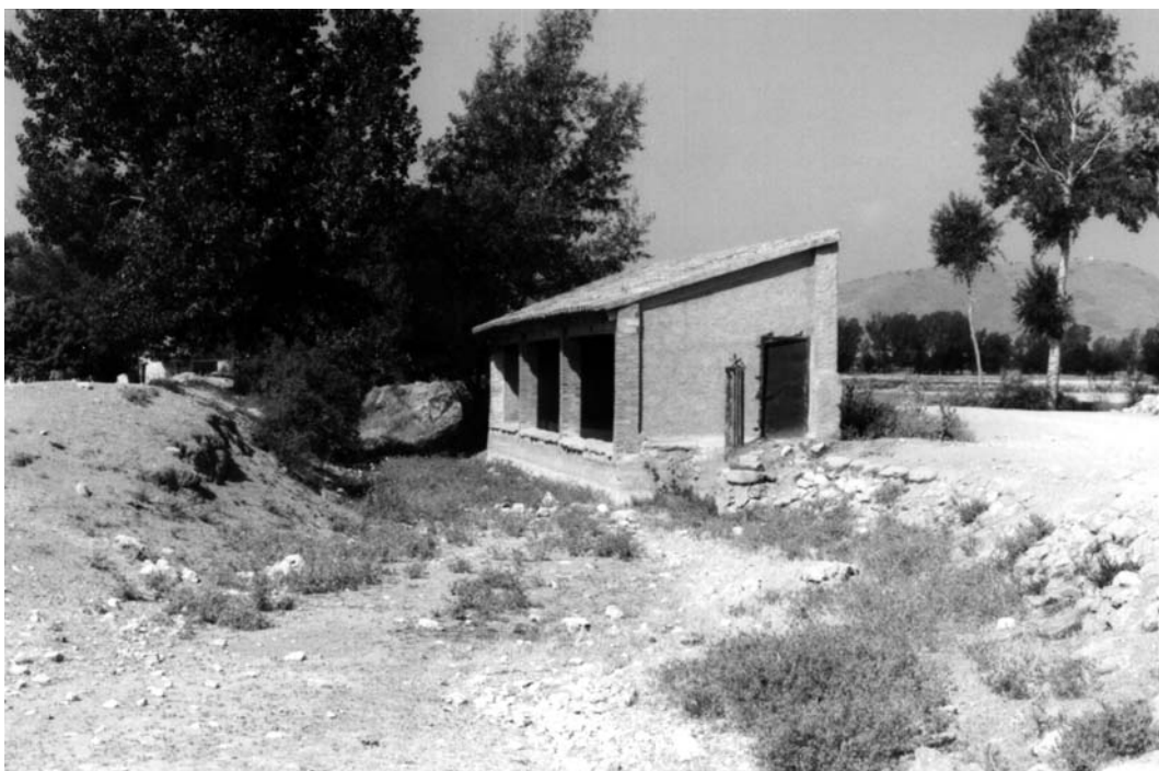
Lavadero de Torrelacárcel.
