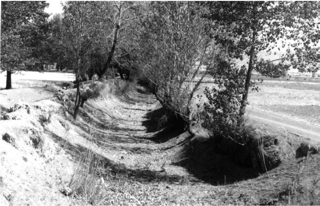
Cajeros del río Cella sin protección vegetal.
