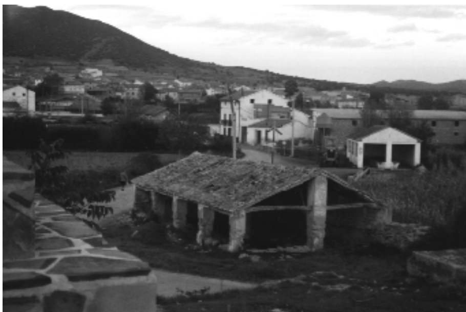
Antiguo lavadero poco antes de su demolición. Navidad 1994 (Foto M. a C. Layunta).
