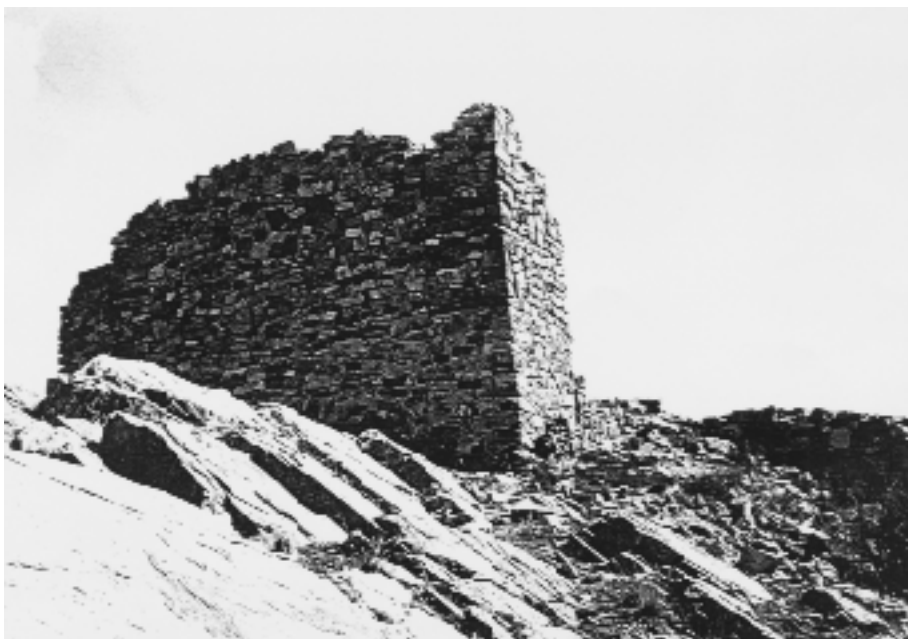
Foto 1 y 2. Detalle del afloramiento cuarcítico, que conforma un escarpe utilizado como barrera defensiva sobre el que se construyó el torreón A.
