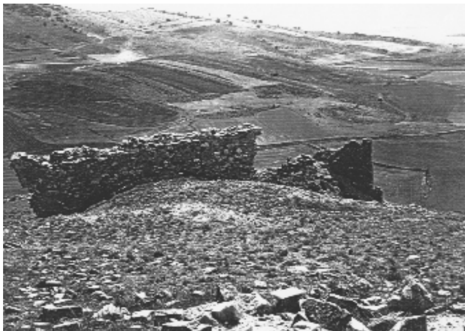
Foto 8. Vista del muro anexo al torreón C desde el aterrazamiento superior.
