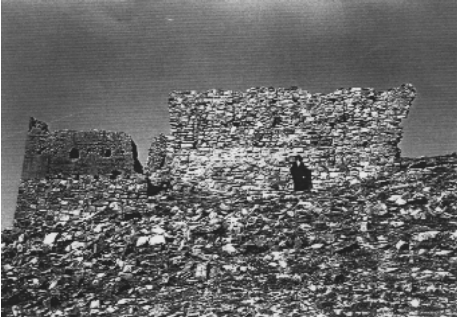
Foto 7. Vista del torreón C y muro anexo, de 9,5 m de longitud y 5,2 m de altura (referencia una persona) desde el aterrazamiento inferior.
