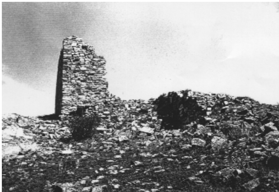
Foto 3. Detalle del torreón A y del muro anexo de 7 m de longitud y 2 m de altura (a la derecha) que separa dos aterrazamientos.
