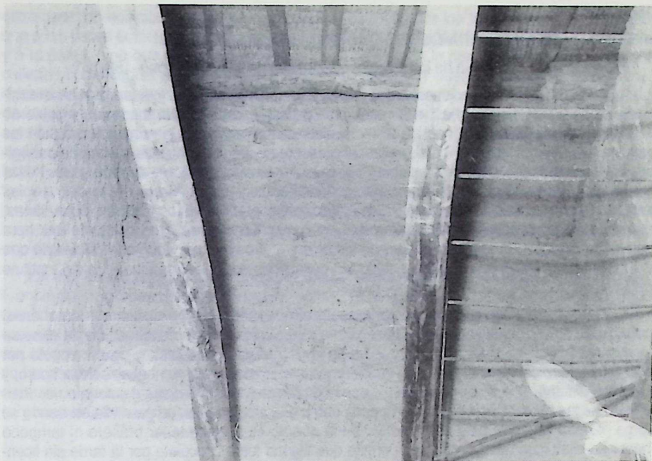
Interior de uno de los departamento sin cielo raso.
