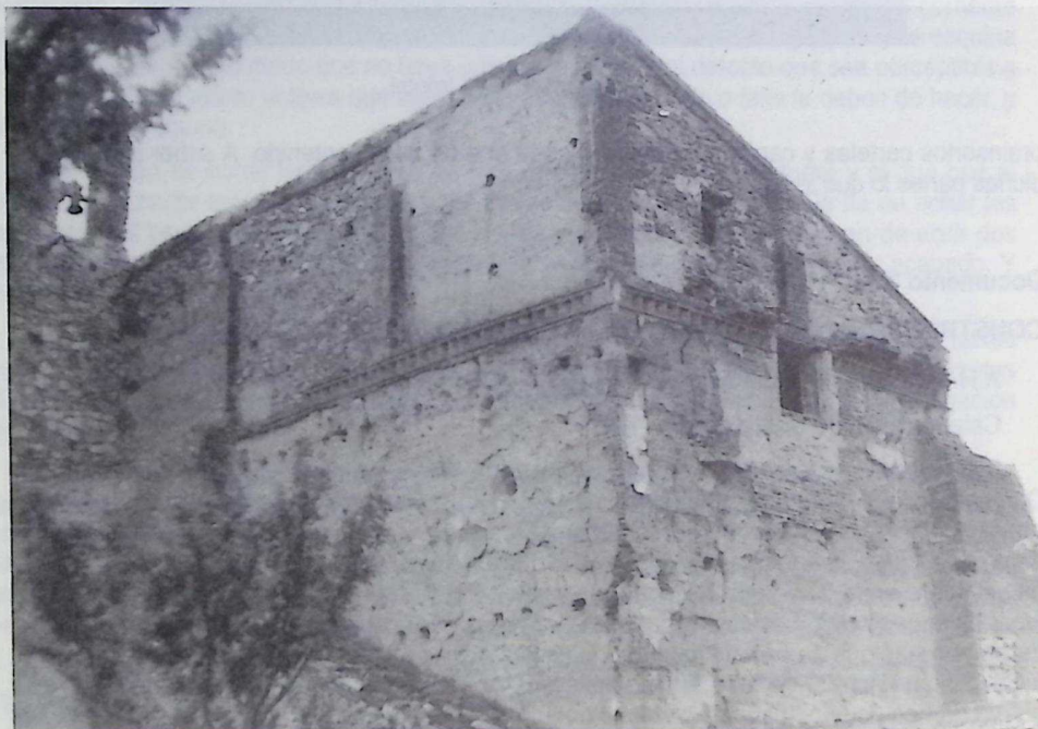
Pared al oeste y tapial del norte.
