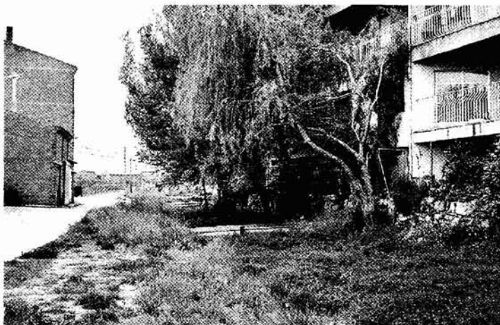
Una de las vías de desembocadura de la rambla de la Hoz a su llegada a Monreal del Campo.
