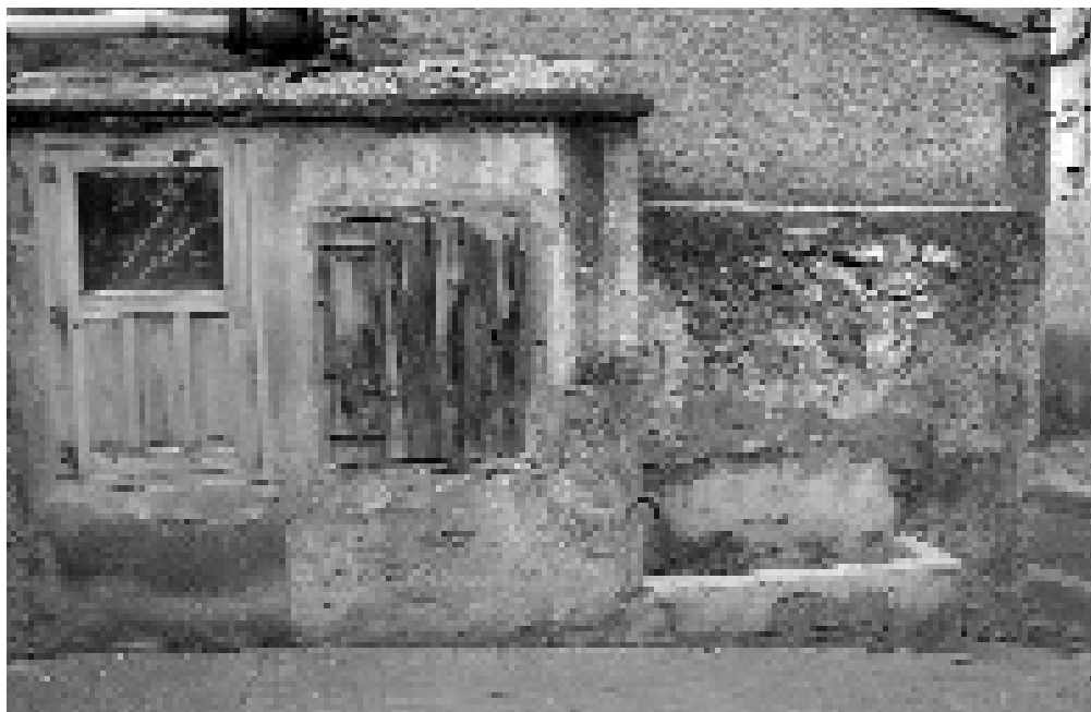
Las solicitudes de apertura de nuevos pozos para acercar el agua a las viviendas fueron muy numerosas.
