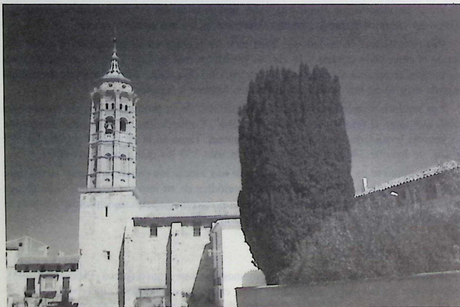
Foto 1. Panorámica de la Torre Mudéjar (Foto: A. Alcañiz)
