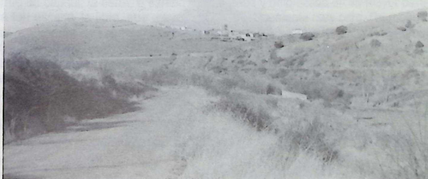
Foto 2. Bádenas. Vista general. Se observa en la loma de la izquierda la ubicación de la ant. fortificación
