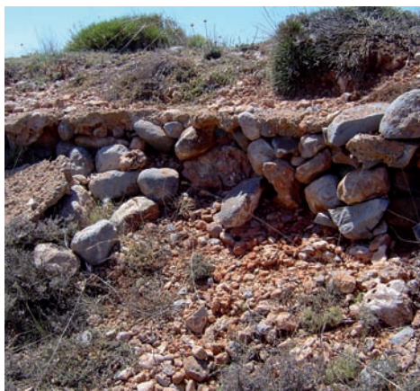
Detalle tejado puesto de mando.
