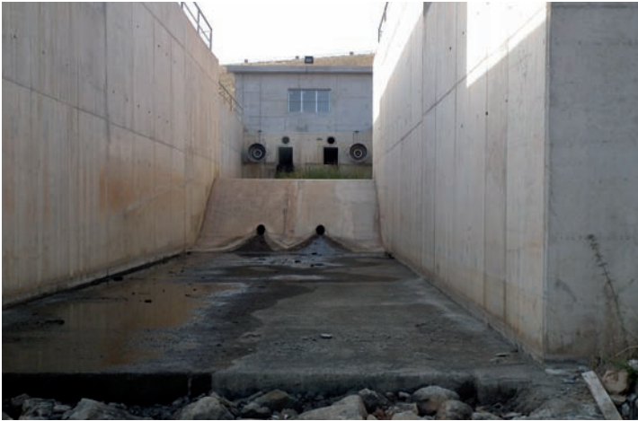
Desagües del pantano de Lechago.
