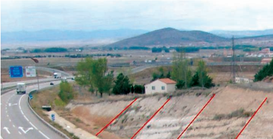
En La Autovía Mudéjar, a la Altura de Calamocha, se puede apreciar el movimiento de las fallas de una manera extremadamente gráfica.
