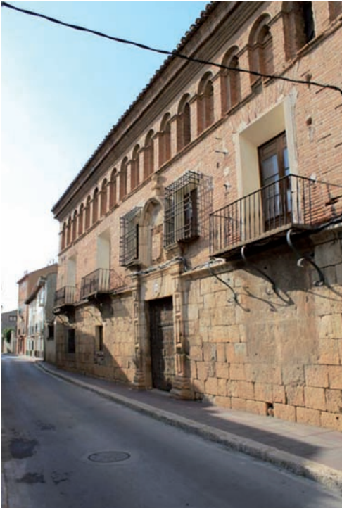
Detalle de la fachada, 2010. Foto Tomás Guitarte.
