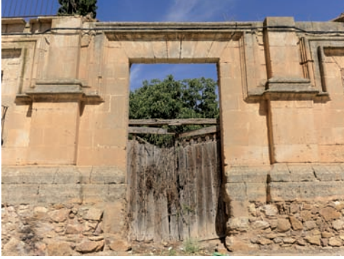
Palacio barroco inconcluso de Used. Puerta de acceso izquierda. Puede apreciarse perfectamente la súbita interrupción de las pilastras que enmarcan el vano por el abandono de la obra, así como el detalle de la moldura que enmarca los sucesivos vanos.
