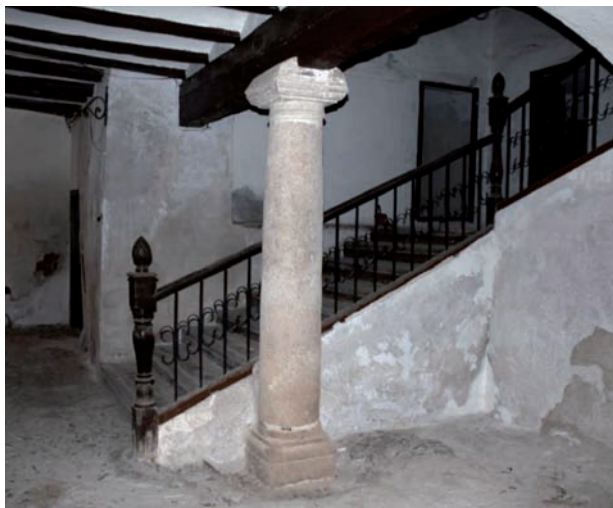
Patio principal y escalera de acceso a la vivienda. Foto Tomás Guitarte, 2010.
